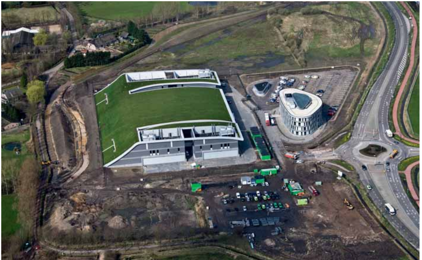
Het nieuwe Rabobank datacenter in Boxtel.
